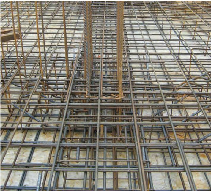
Elemento portante della struttura edilizia che viene collegata staticamente al suolo trasmettendone le sollecitazioni dovute ai carichi. È fondamentale la cura con cui si getta in opera la struttura in conglomerato cementizio per garantire un'impermeabilizzazione ottimale rispetto al fondo sottostante.
